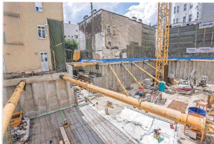
**AUSSTEIFUNG** Die Baugrube wurde mittels hydraulischer Stahlsteifen und Litzenanker ausgesteift.
